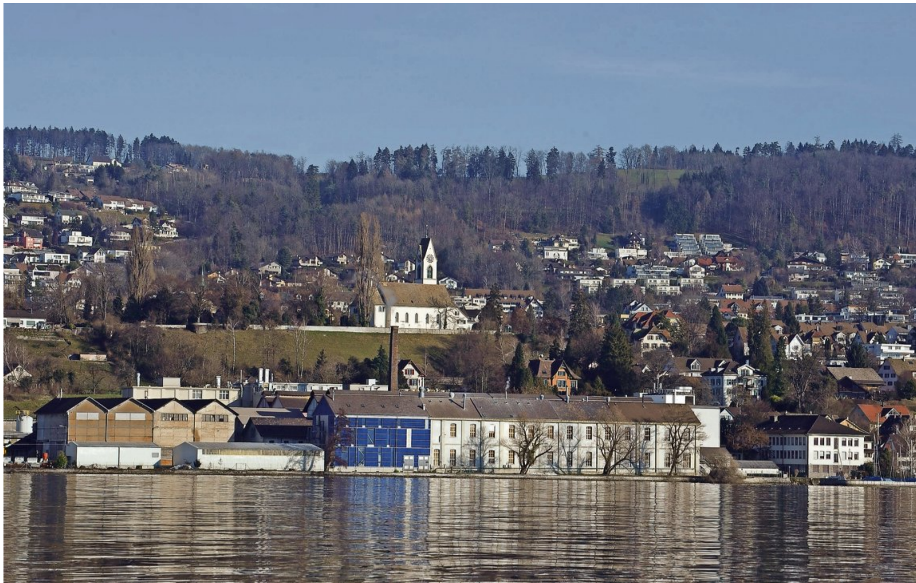
Uetikon mit dem Gelände der Chemiefabrik ist einer der Orte am See, in denen die Planungsgruppe grosses Ausbaupotenzial sieht.
