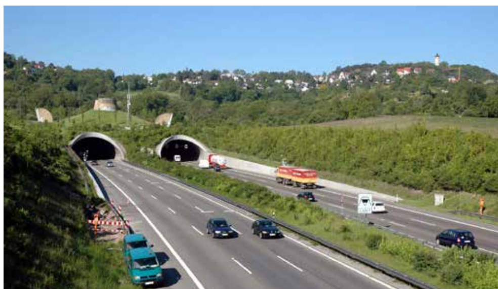
Die Tieflegung von Bahn und Strasse befreit die Dörfer vom Durchgangsverkehr und eröffnet den erhofften Zugang ans Wasser.
